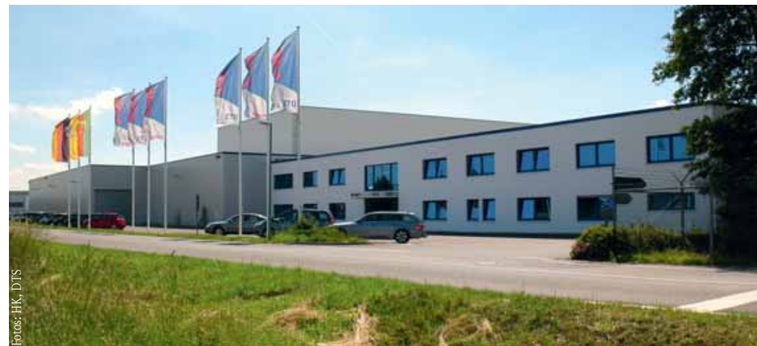
Hauptsitz von DTS Systemoberflächen in Möckern
